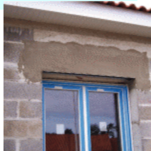
Traitement du coffre tunnel avec le mortier fibré planicoffre de chez PRB
