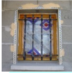
pose de baguette d'angle en tableaux et voussures avant projection d'enduit
